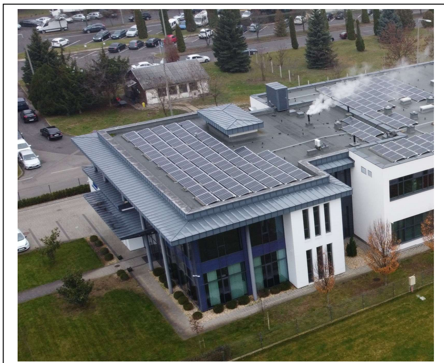
56,25 kW teljesítményű napelemes rendszer
